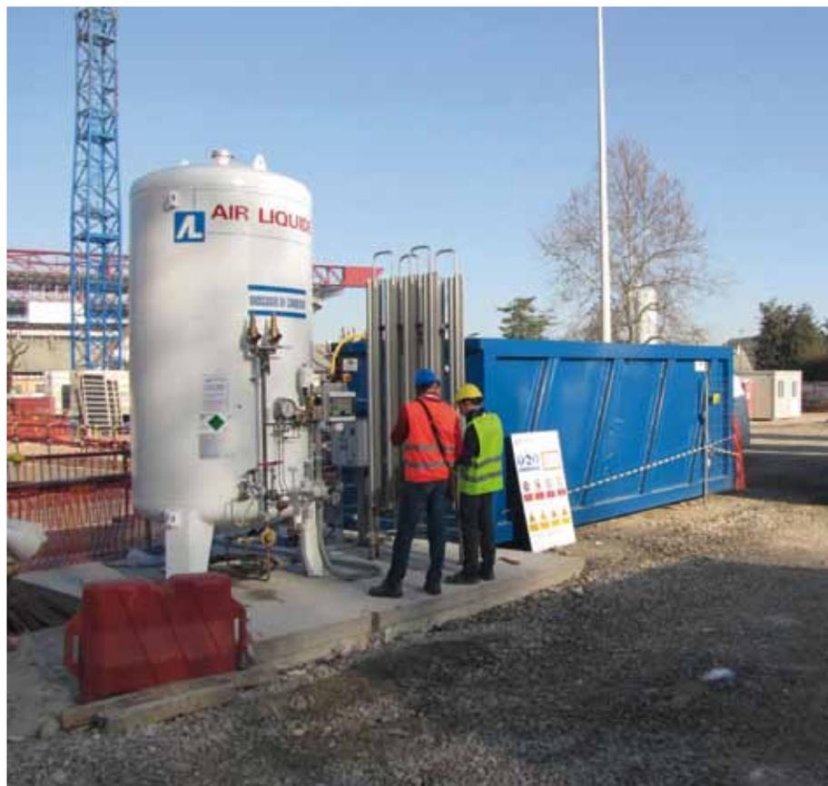
necessario correggere il pH dall'aggotamento delle acque di falda provenienti dagli scavi della stazione non ancora impermeabilizzata. L'installazione, in breve tempo, di 8 impianti di neutralizzazione con CO<sub>2</sub> ha permesso di trattare in modo graduale le acque reflue alcaline e di controllarne il pH; il protagonista di questa tecnica è il diossido di carbonio, prodotto naturale, atossico, non infiammabile, sicuro nello stoccaggio e facile da maneggiare.
