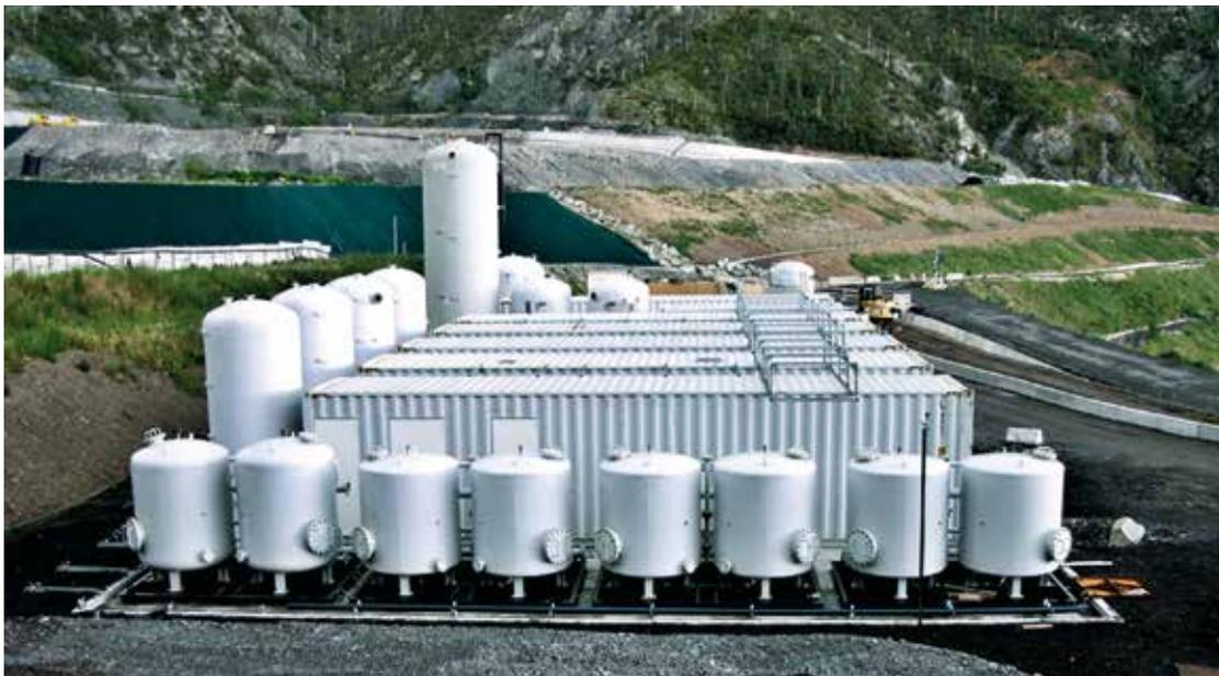
*Per il trattamento del percolato, SIMAM propone al mercato impianti basati su processi fisici riconducibili alle varie tecnologie di filtrazione su membrana*
