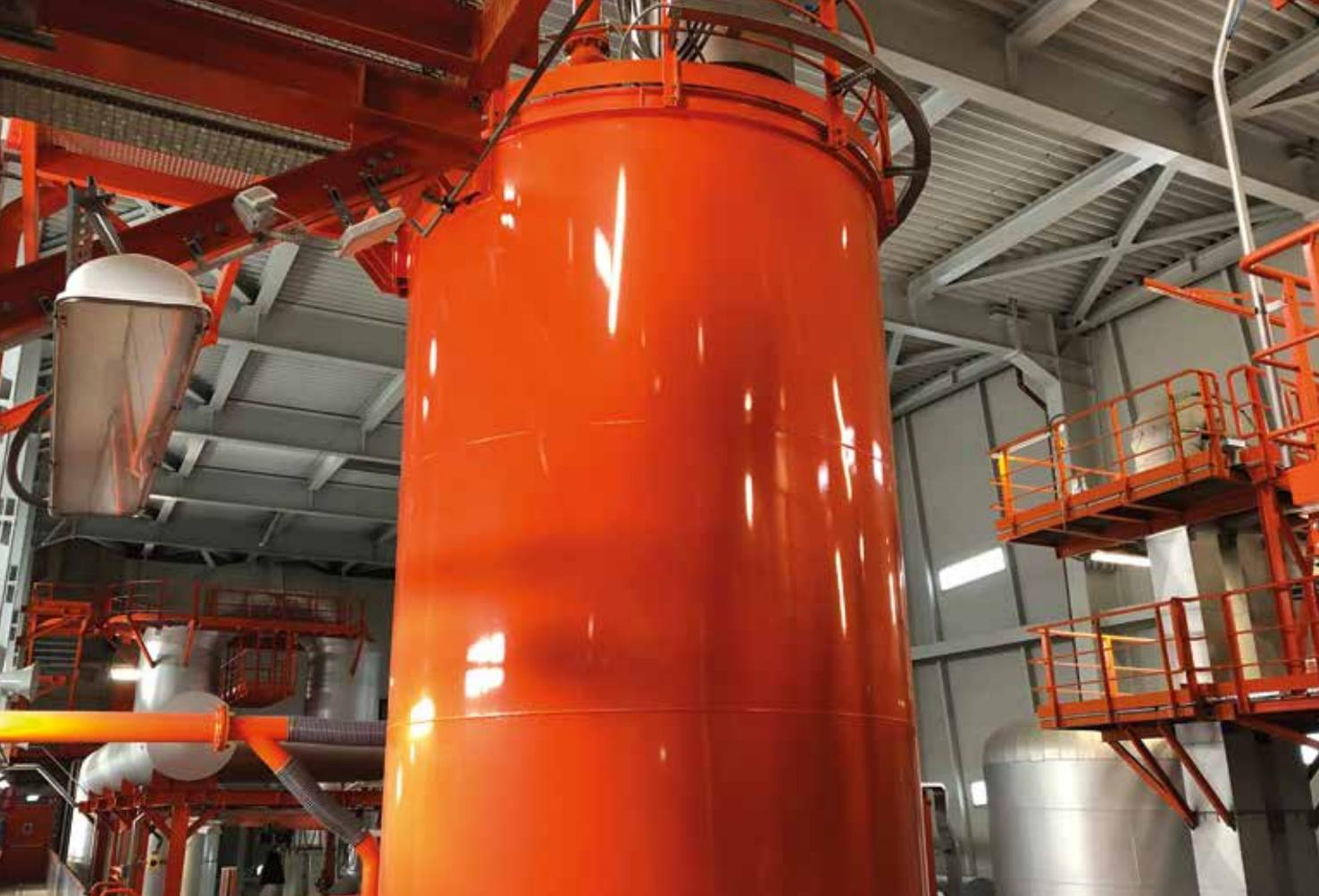
*...per abbattere questi inquinanti, si ricorre ad un primo stadio a secco, che dosa calce e carboni attivi, e ad un secondo stadio a secco e in cascata che, con un mix di bicarbonato di sodio e di carboni attivi, completa il sequestro*
