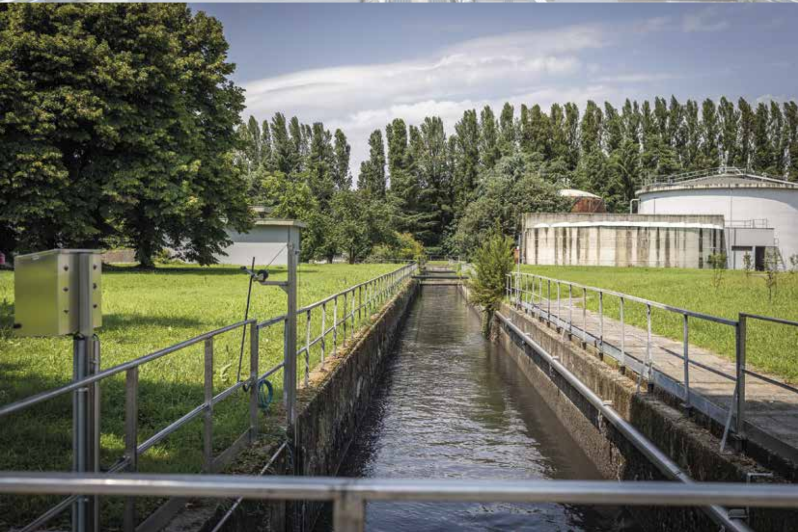
Impianto di depurazione CAP Evolution di Peschiera Borromeo (MI).
