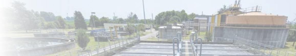
Impianto di depurazione di Bresso-Niguarda (MI).
