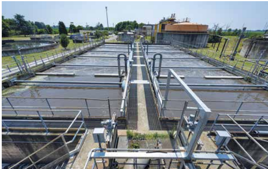
Depuratore di San Giuliano Ovest.
